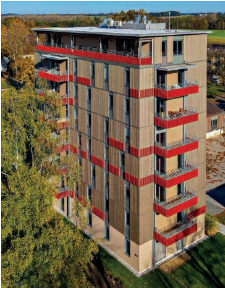
Abb. 22 Das „H8“ in Bad-Aibling ist bis auf den betonierten Treppenaufgang und Aufzugsschacht ein reiner Holzbau. (© Huber & Sohn GmbH & Co. KG).
