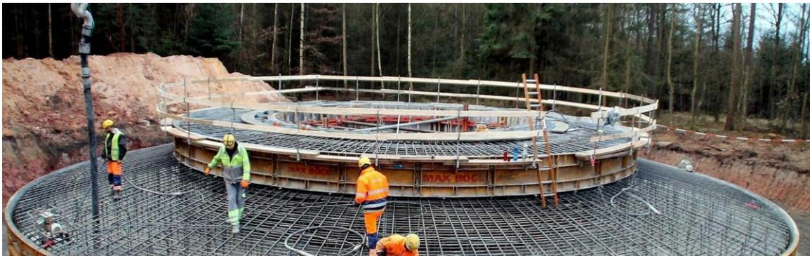
**Bild 7: Fundament für eine Windkraftanlage.**
